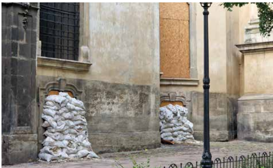
Sacos de areia e painéis de madeira a proteger estruturas
